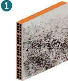
Preparar la superficie de la pared a revestir, eliminando restos de revoques.
