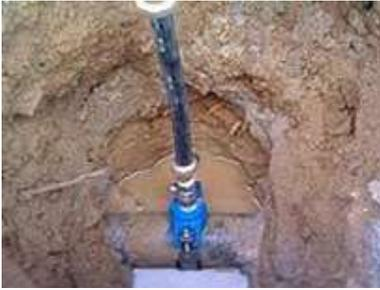
La unión a la tubería principal se realiza normalmente con un collarín de hierro fundido. Cuando se necesita una tubería de acometida de un diámetro grande se suele utilizar una pieza especial en forma de T.
