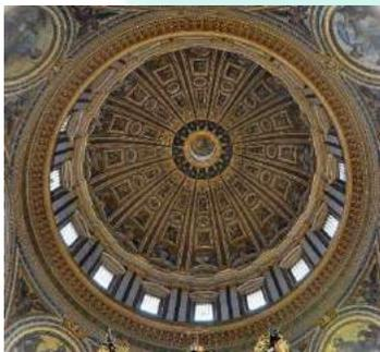
Se comenzó a utilizar casetones, adornos huecos geométricos. Es una técnica ya utilizada en la antigüedad clásica: un ejemplo típico se da en el Panteón de Agripa.
